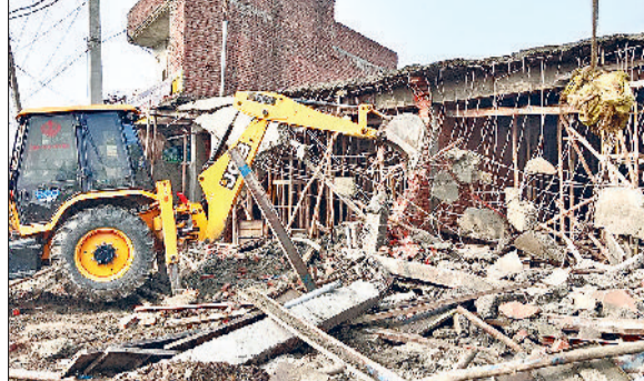
इंदी। गांव मटकमाजरी के पास बन रहे निर्माणाधीन शोरूमों पर चलता पीला पंजा।
